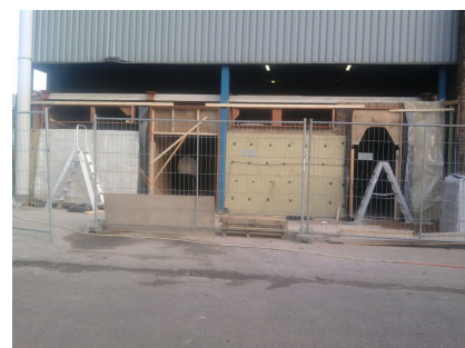
Sanitairgroep in aanbouw
